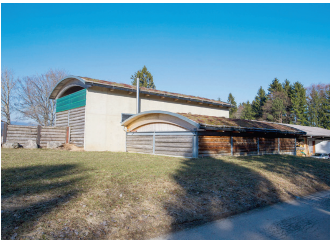
La chaudière n'occupe qu'une petite partie du bâtiment, le reste sert de dépôt à la commune de Bassins. S. HARO
